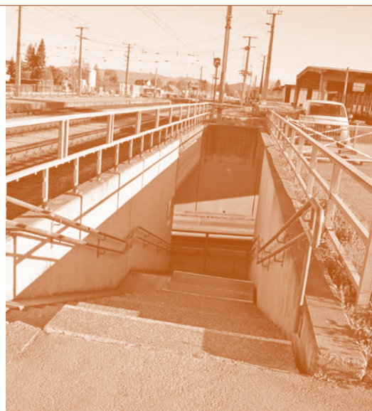
Die Unterführung Landammann-gasse vor Beginn der Bauarbeiten.
