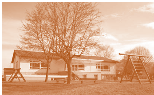
Die Fassade des Kindergarten Brederis wird saniert.
